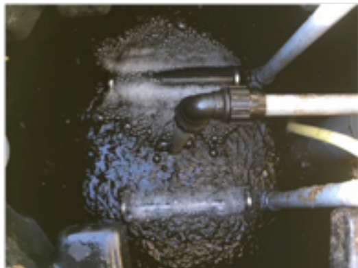
Essais sur différents types de diffuseurs fines bulles, afin de proposer la solution combinant efficacité et économie.
